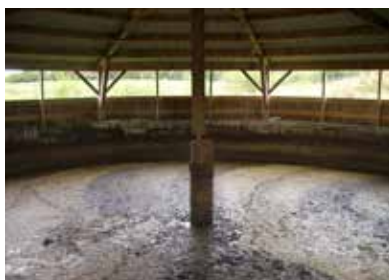
Les boues en excès sont dirigées vers la fosse.
